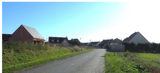
Photo 9 : RD548 – depuis Silly-le-Long
